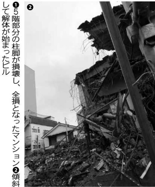
① 5階部分の柱脚が損壊し、全壊となったマンション②傾斜して解体が始まったビル
