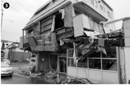
①この地域では、竹を縛り縫った木舞(小舞)を柱と梁の間に入れ下地を作り、土を塗り、しっくい仕上り土壁の住宅も多い。筋交いはなく、地震の揺れに対しては弱い。②1階がつぶれた住宅③全壊となった商店
