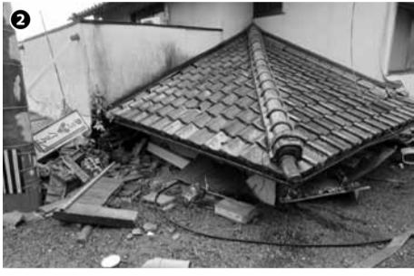
①この地域では、竹を縛り縫った木舞(小舞)を柱と梁の間に入れ下地を作り、土を塗り、しっくい仕上り土壁の住宅も多い。筋交いはなく、地震の揺れに対しては弱い。②1階がつぶれた住宅③全壊となった商店
