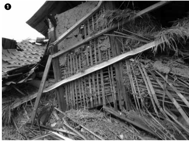
①この地域では、竹を縛り縫った木舞(小舞)を柱と梁の間に下地を作り、土を塗り、しっくい仕上りした土壁の住宅も多い。筋交いはなく、地震の揺れに対しては弱い。②1階部分が座屈した住宅③波打つ路面
